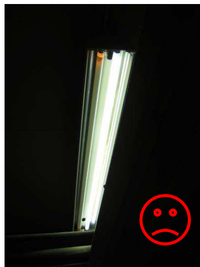
Figur 10. Lysarmaturer som står og gnistrer uten å tenne, er et stort risikomoment i produksjonslokaler med mye støv.
