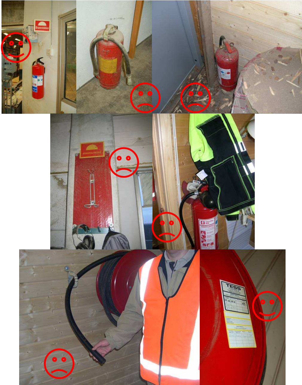
Figur 21. Det er mye å passe på! Alle ansatte må føle et ansvar og melde fra dersom det oppstår feil. Egenkontroll er en metode for fortløpende å sikre at ting er i orden.
