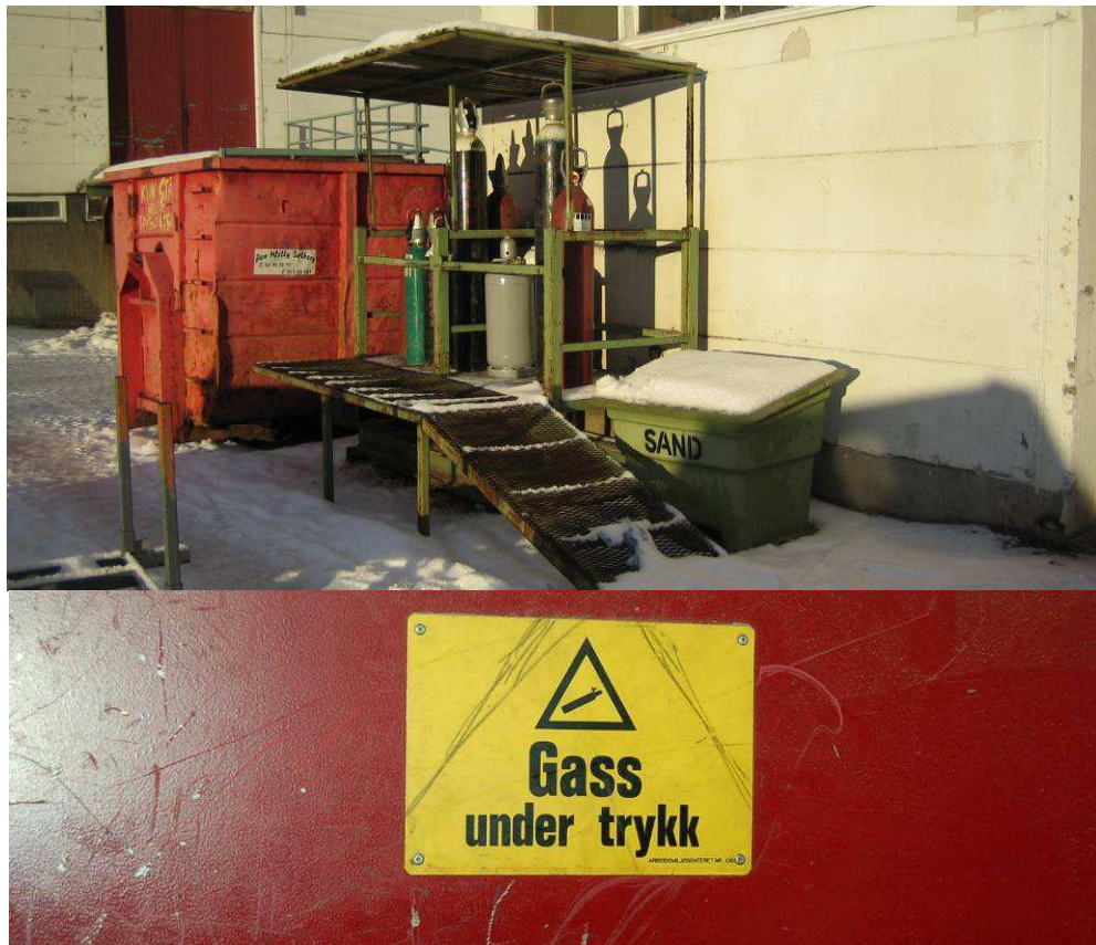
Figur 16. Gassflasker skal stå på fast avgrenset område. Merke skal vise hvor gass oppbevares.
